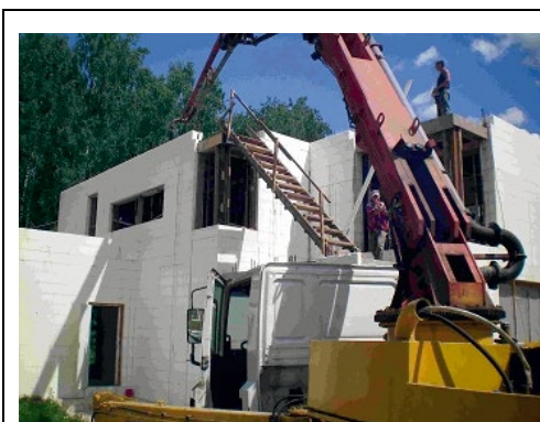
Рис.8 Заливка бетона с помощью бетононасоса
