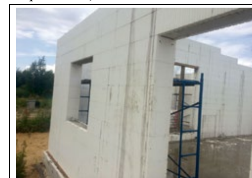
Рис.7 Возведение оконных проемов
