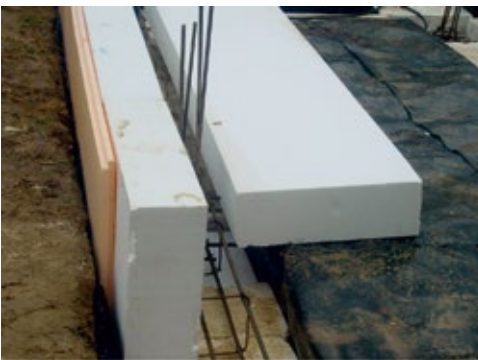
Рис.2 Утепление фундамента
