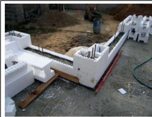
Рис.3 Монтаж первого ряда блоков несъемной опалубки
