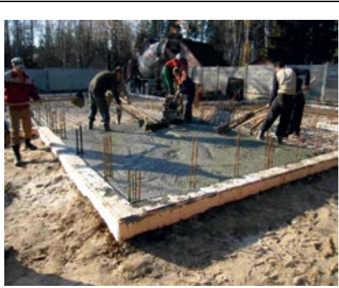
Рис.1 Возведение и утепление фундамента
