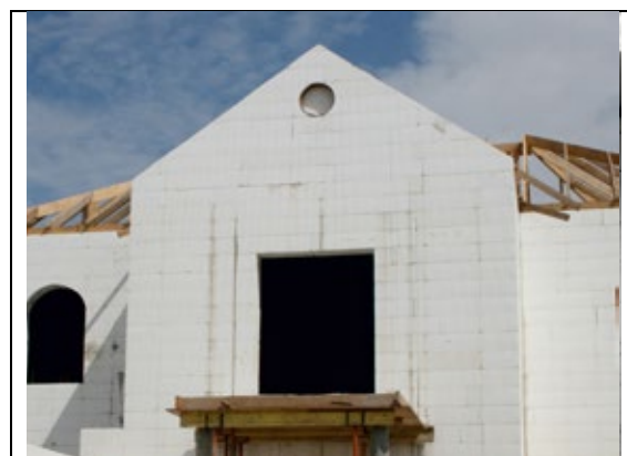
Рис.12 Возведение фронтона
